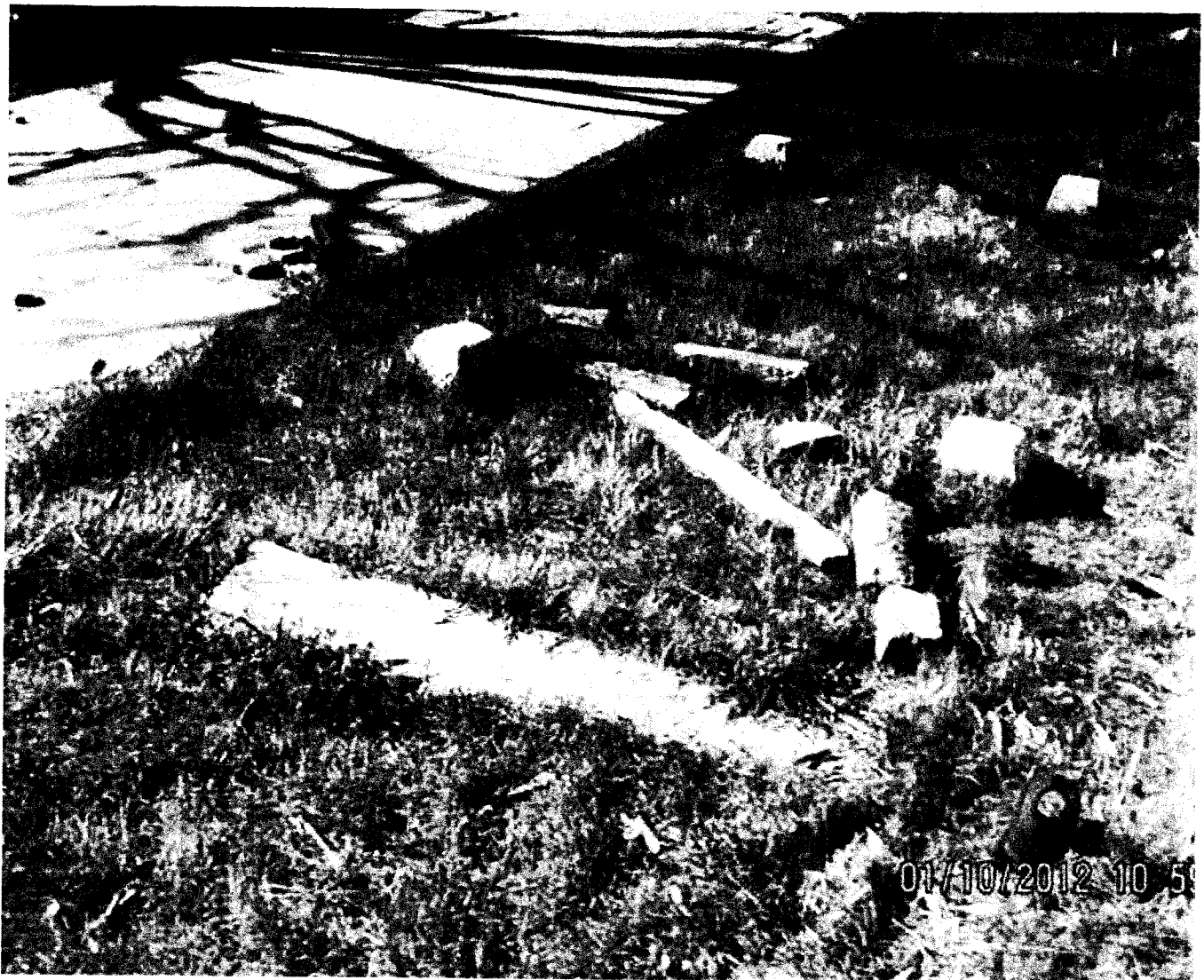
Photo taken on the parcel D Jurden, CET - 01/10/2012
